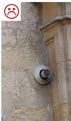
Ventouse de chaudière : lorsque la sortie horizontale ne peut se faire sans dénaturer la façade, il convient d'opter pour la ventouse verticale (sortie en toiture), de préférence dans un ancien conduit de cheminée.
