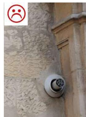
*Ventouse de chaudière : lorsque la sortie horizontale ne peut se faire sans dénaturer la façade, il convient d'opter pour la ventouse verticale (sortie en toiture), de préférence dans un ancien conduit de cheminée.*
