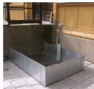
Plateformes élévatrices intégrées : les marches se transforment en plateforme, avec boîtiers de commande haut et bas sur potelet et /ou encastrés.
