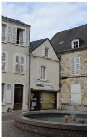
A partir du XVIIe siècle, le style Classique s'est imposé et avec lui la façade de pierre des bâtiments les plus représentatifs. Comme dans de nombreuses villes on a caché la façade en pan de bois. La structure ancienne se révèle alors par la poutre sablière au dessus du RdC et les étages en encorbellement. Certains bâtiments ont conservé une face en pan de bois (pignon en-dessous). Cette manière stylistique est ainsi devenue un témoin de l'esprit de l'époque.
