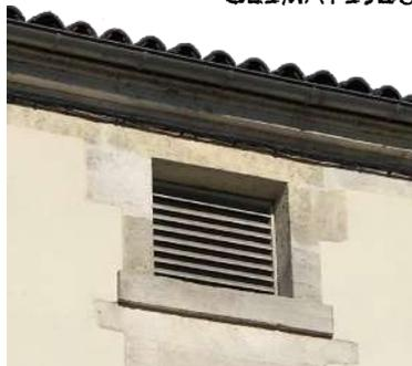
*Intégration d'une grille de ventilation de pompe à chaleur ou climatiseur dans une fenêtre de comble.*
