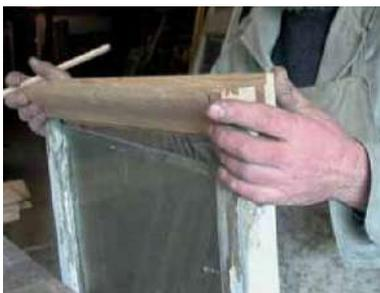
Travail de remplacement d'une traverse basse avec jet d'eau : les fenêtres en bois anciennes, le plus souvent en chêne, sont réparables.
