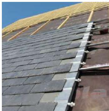
Capteurs solaires invisibles sous les ardoises.
