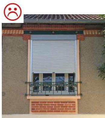
Le volet roulant a été posé avec coffre apparent et coulisses dans le même plan que la façade et non contre la menuiserie.
