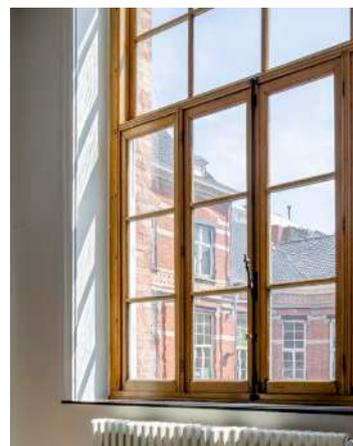
FINÉO fabriqué par AGC Glass Europe (Belgique) : nouveau vitrage isolant alliant les qualités thermiques du triple vitrage et l'épaisseur et la légèreté du simple vitrage, conçu pour s'intégrer dans les châssis existants à simple vitrage.
