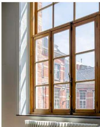
FINÉO fabriqué par AGC Glass Europe (Belgique), vitrage isolant alliant les qualités thermiques du triple vitrage et l'épaisseur et la légèreté du simple vitrage, conçu pour s'intégrer dans les châssis existants à simple vitrage.
