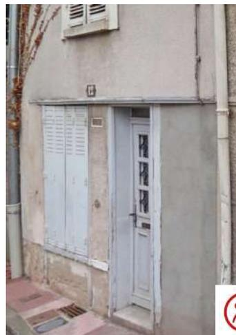
Enduit ciment sur façade à pan de bois caché : pour la pérennité de la structure bois, l'enduit ciment doit être déposé.
