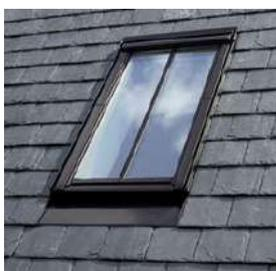
Fenêtre de toit encastrée dans couverture tuile (ne dépassant pas de la surface de la toiture).
