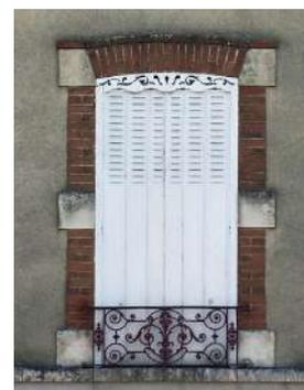
Un lambrequin en bois ou en métal découpé, peint, est utilisé ici pour masquer le faible vide entre la courbe du linteau et l'horizontale des volets en acier ; il peut être employé pour masquer une coffre de volet roulant.
