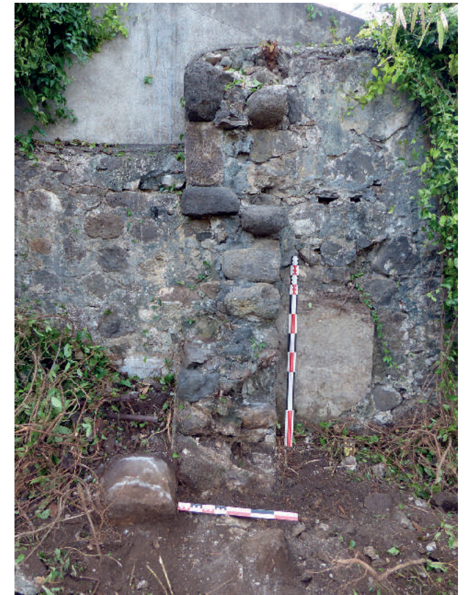
[Fig. 7] : Détail d'un arrachement observé dans le mur oriental de la parcelle, mis en relation avec le mur F34 identifié dans le sondage n° 1 (photo P. Georges / Inrap)
