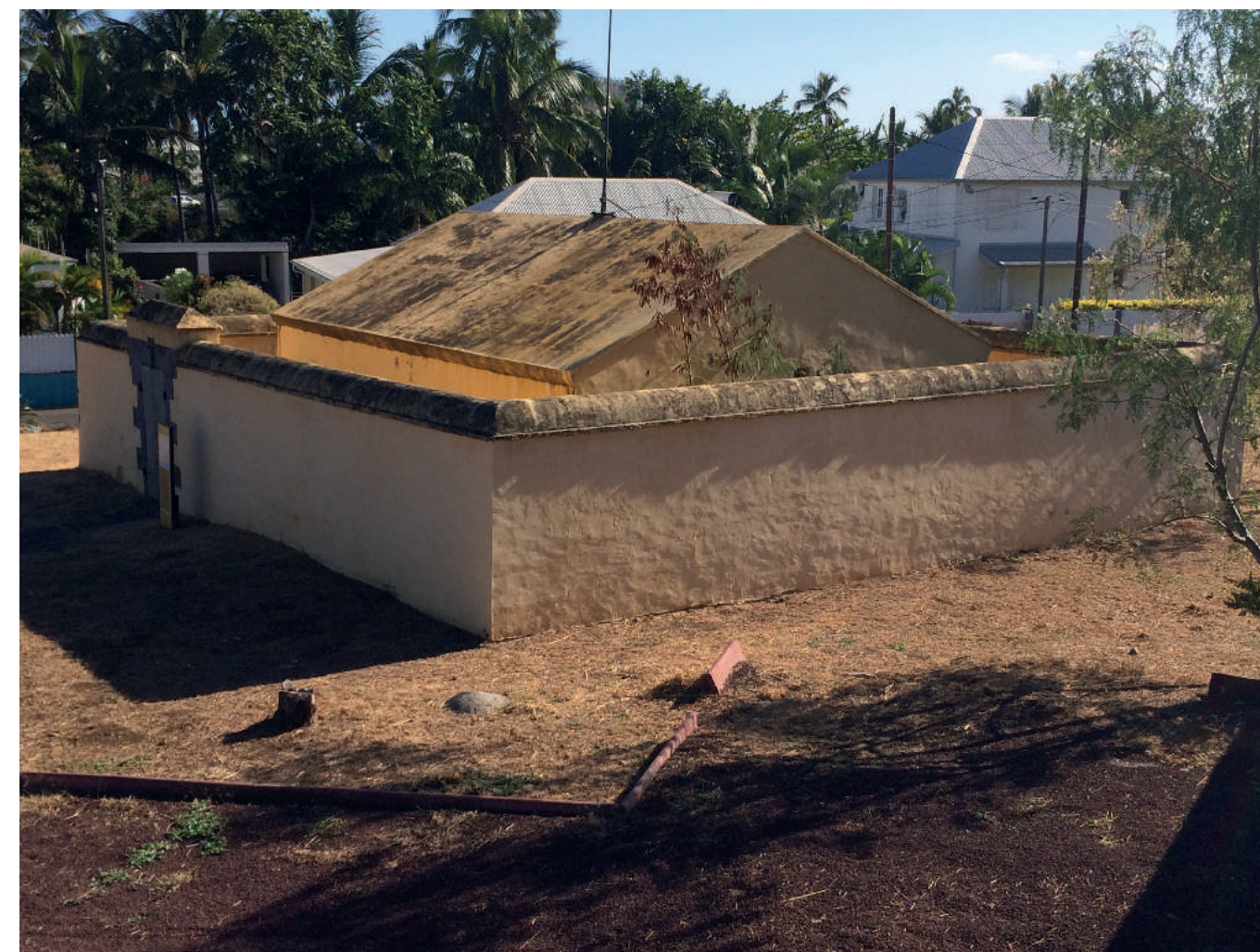
[Fig. 1] : Vue générale de la poudrière depuis le sud (photo Th. Cornec / Inrap)
