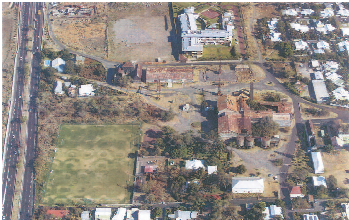
[Fig. 3]: Vue aérienne de l'usine (photo H. Douris / Agence Up)
