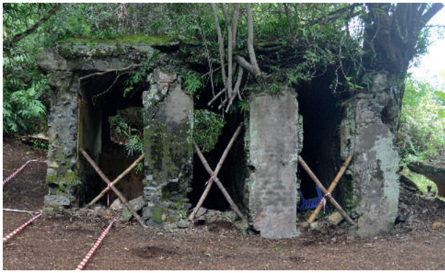
[Fig. 1]: Vue des vestiges en élévation des cachots, depuis le nord (photo M. Legros)
