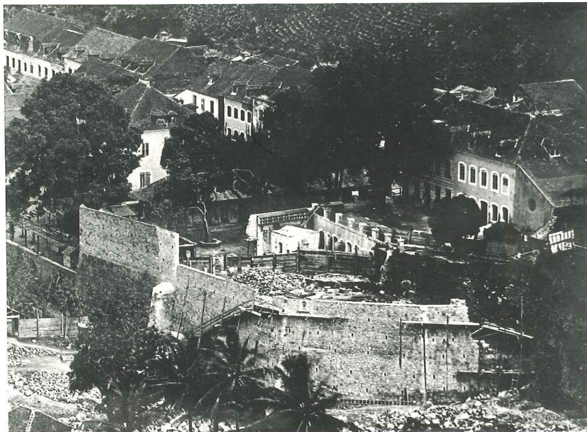
fig. 4 Maison Coloniale de Santé en 1870, vue depuis le sud-est. Au premier plan, le mur de soutènement en cours de construction (Coll. Breau du Pat.)
